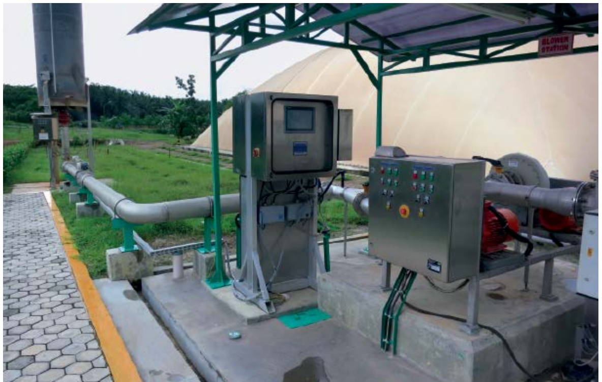
Das Gasanalysesystem INCA misst die Zusammensetzung von Erdgas – wie hier in einer Biogasanlage in Indonesien (Foto: Torsten Haug)
