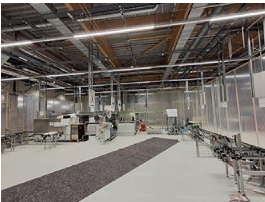
Bildunterschrift Bild 6: Die Anlage wird im Zuge des Umzugs erweitert und die Fertigungskapazität gesteigert.
