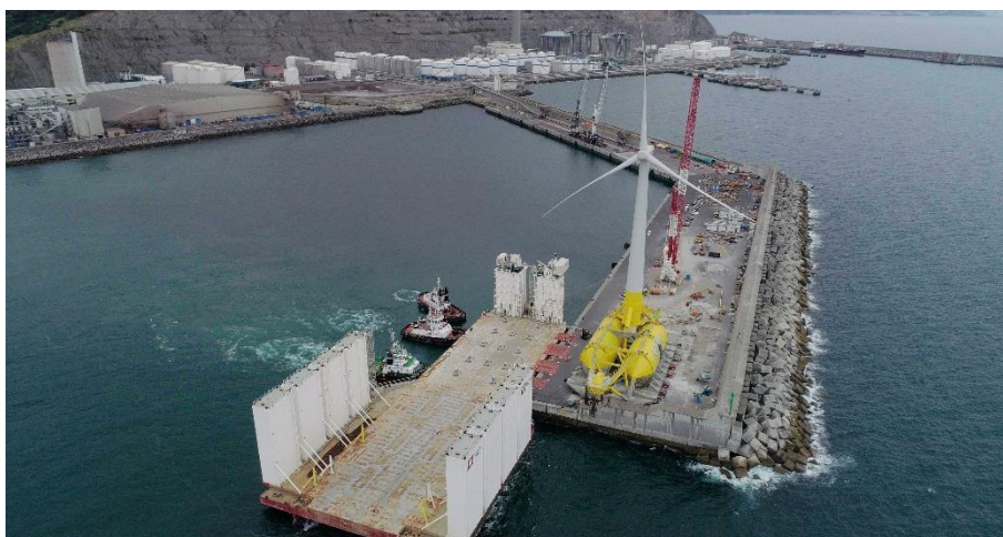
Verladen des DemoSATH-Fundaments samt Windturbine auf das Halbtaucherschiff
