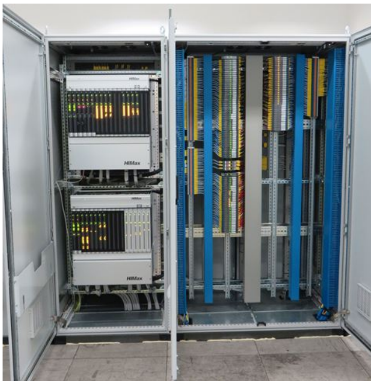
Bildunterschrift: HIMax-Sicherheitssysteme im PES-Schrank
