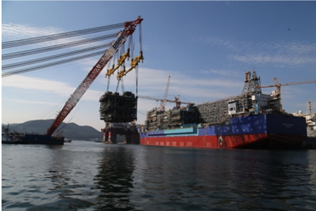
Abbildung 2: Das MEG (Monoethylenglykol)-Injektionsmodul wird erfolgreich auf den Rumpf des FPSO-Schiffs in Südkorea installiert. Das FPSO-Schiff dient der schwimmenden Förderung, Lagerung und Entladung.
