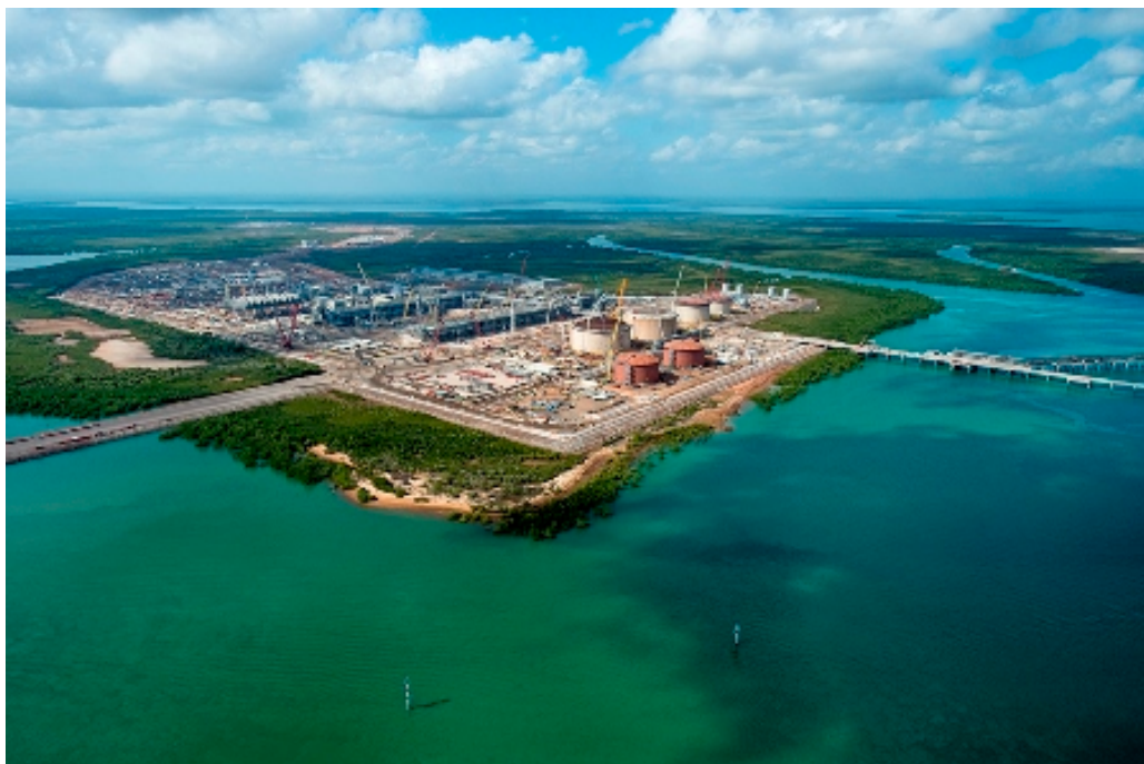
Abbildung 1: LNG-Projekt Ichthys: Onshore-Anlage.
